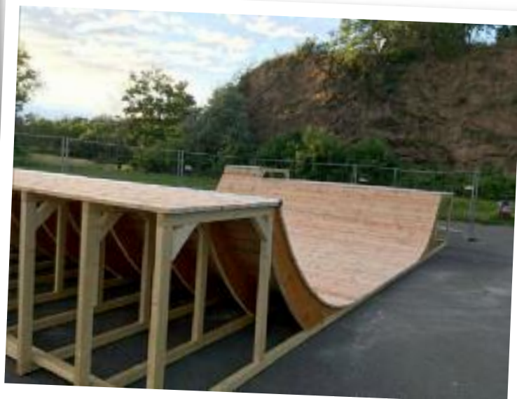
Die neue Skaterbahn am Galgenberg im Aufbau
